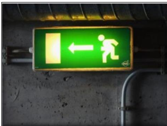
Figura 9 - Sinalização iluminada com fonte de luz própria
