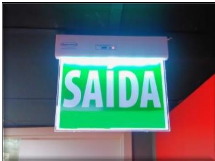
Figura 8 - Sinalização iluminada com fonte de luz própria
