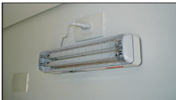
Figura 10 - Bloco Autônomo
